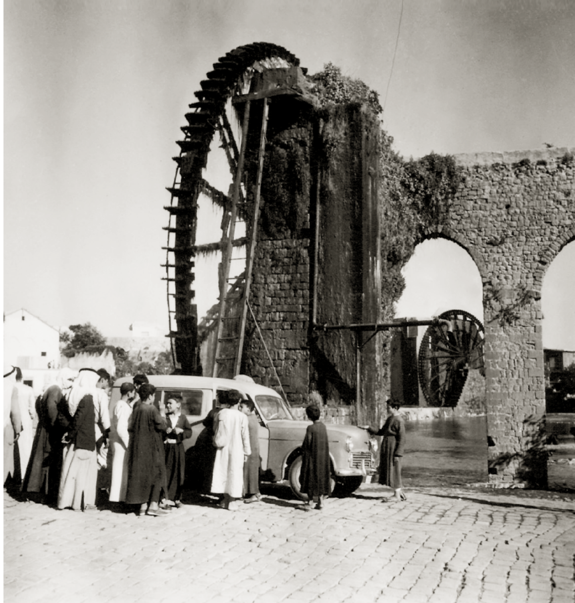
Große hölzerne Wasserschöpfräder (Noira) mit Viadukt, 1953 Menschenansammlung am Hillman Minx Station Wagon.
