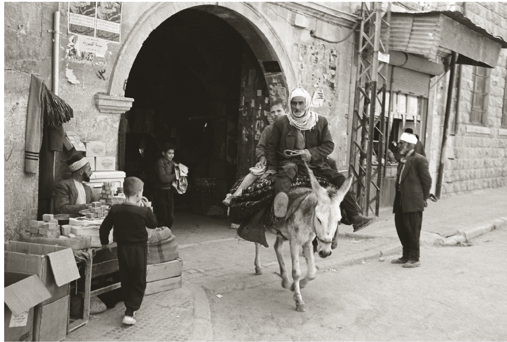
Eingang zum Suq, 1960 Entrance to the souk, 1960
