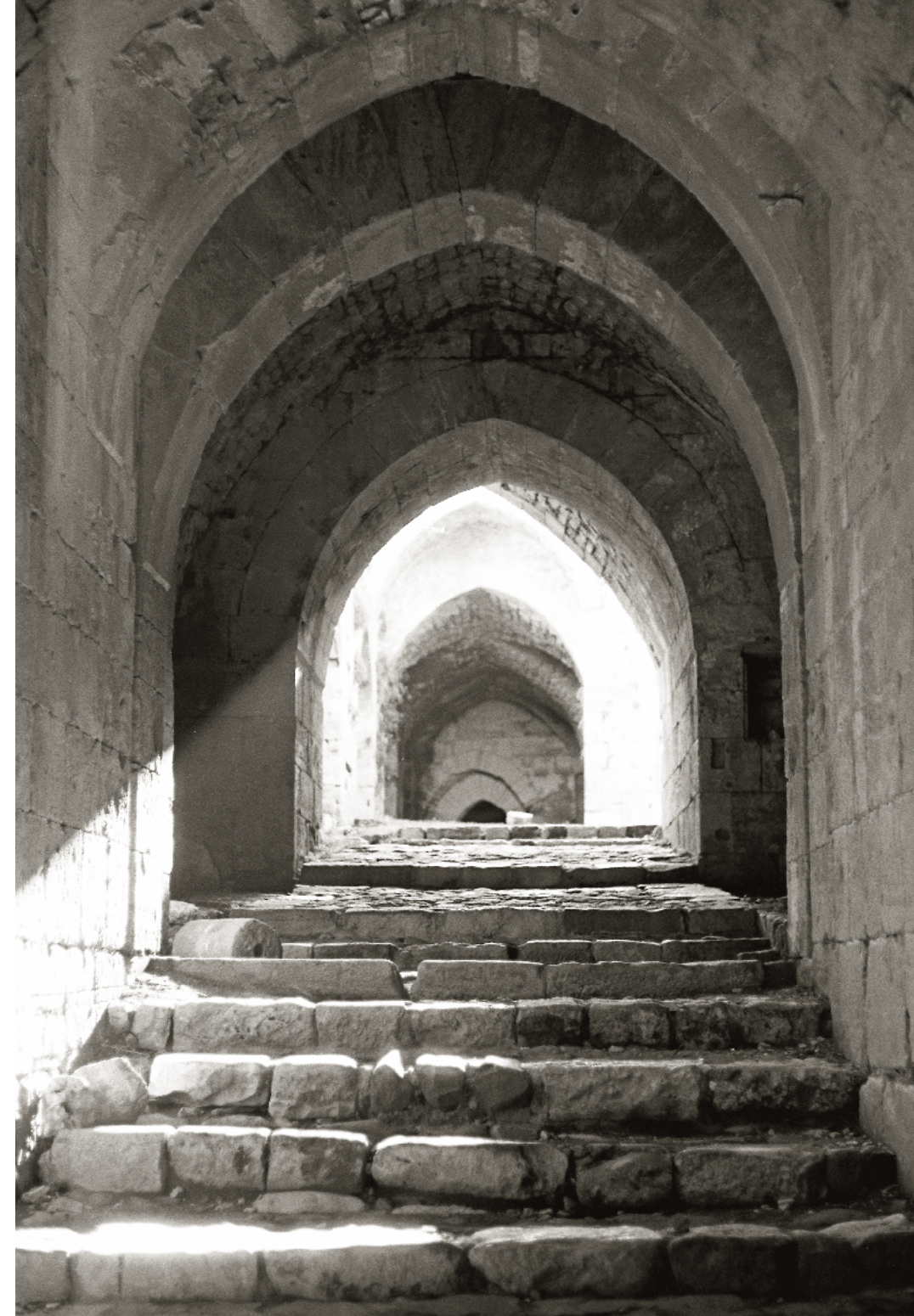
Torweg der Unterburg, 1960
