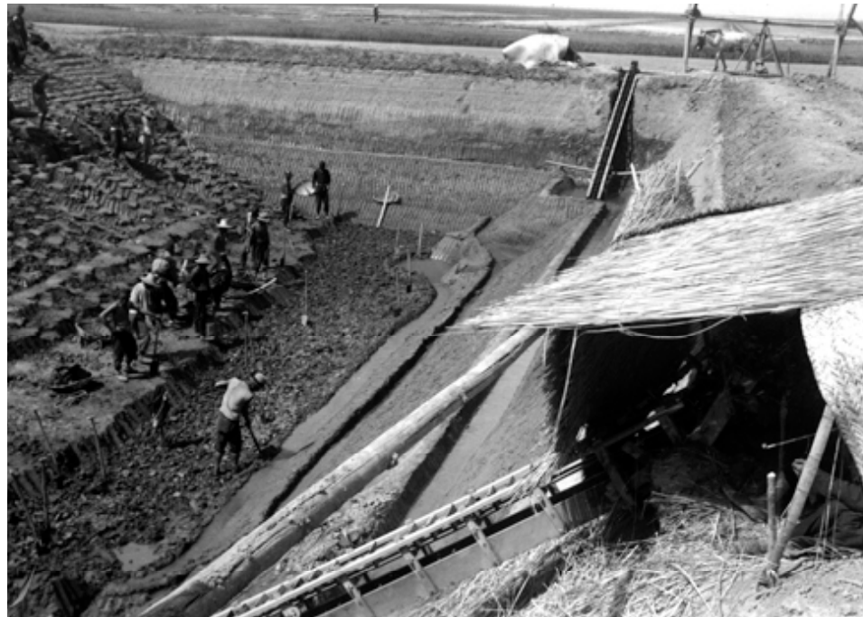
Tianjin (früher: Tientsin) Lehmstich zur Ziegelgewinnung am Haihe, 1938. „Der löss- und quarzhaltige Boden am Fluss war ideal zum Brennen von Ziegeln und sorgte für den Aufschwung der Ziegeleien.“
